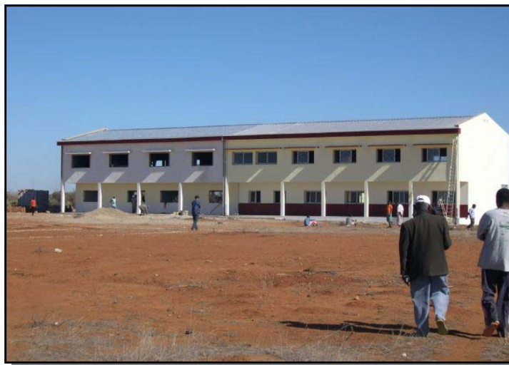
Le collège tenu par l'Assomption, en construction.
